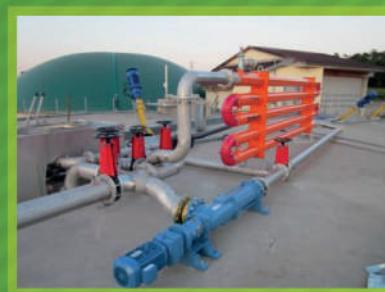
Pompes dilacératrices, échangeurs Bio-Heat
