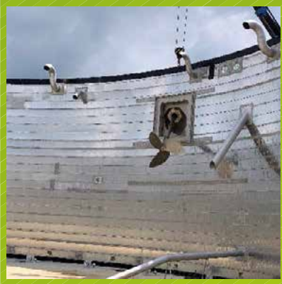
Digesteur LIPP - de 28 x 8 mètres avec agitateur Mammut et couverture BAUR FOLIEN
