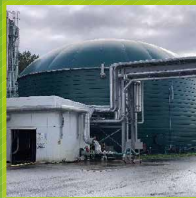
Digesteur LIPP - de 28 x 8 mètres avec agitateur Mammut et couverture BAUR FOLIEN
