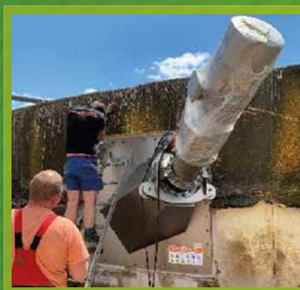
Remise à niveau d'installations existantes, carottage, pose par nos techniciens
