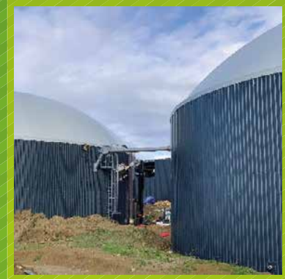
Digesteur LIPP - de 28 x 8 mètres avec agitateur Mammut et couverture BAUR FOLIEN
