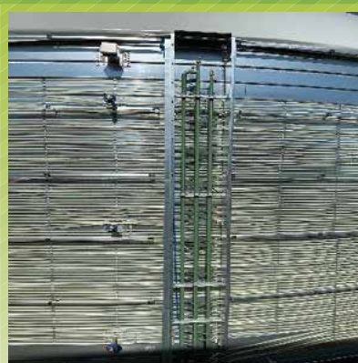
Chauffage intégré sans contact avec le digestat
