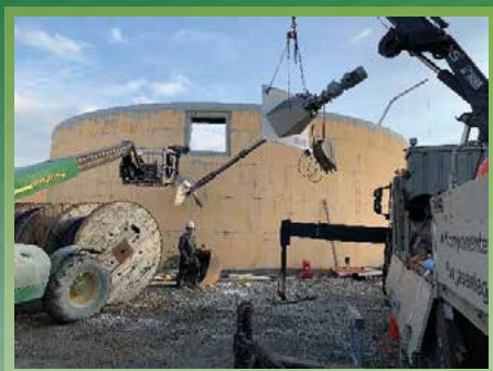
Nous pouvons également vous proposer la mise en place des anneaux de chauffage
