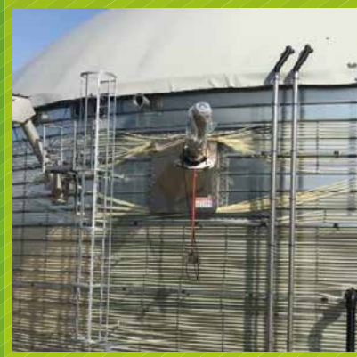
Digesteur LIPP - de 28 x 8 mètres avec agitateur Mammut et couverture BAUR FOLIEN
