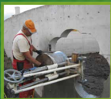
Remise à niveau d'installations existantes, carottage, pose par nos techniciens
