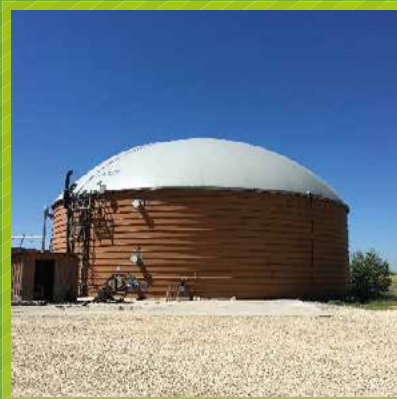
Digesteur LIPP - de 28 x 8 mètres avec agitateur Mammut et couverture BAUR FOLIEN
