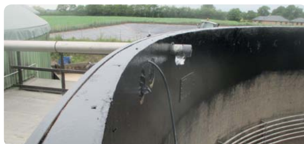
Ouvrage en béton ayant été réparé avec notre System RELEST®Protect.
