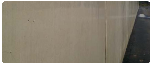
Béton traité avec Controll®Innerseal
