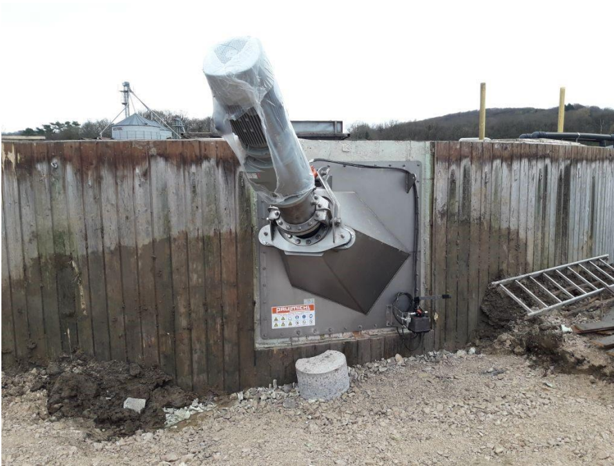
GAEC COURTOIS Monsieur Courtois 70300 EHUNS Mise en place dans le digesteur d'un agitateur Mammüt
